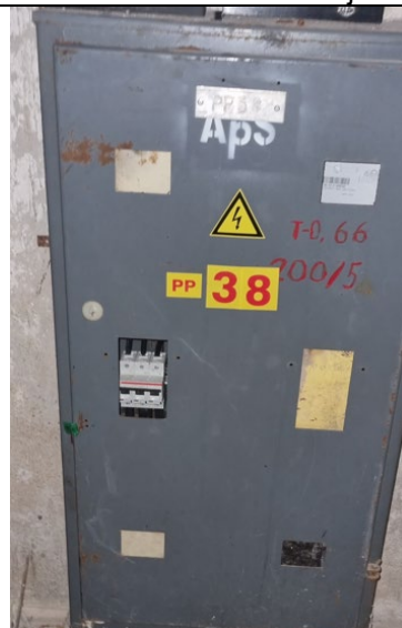
Foto: elektros instaliacija
